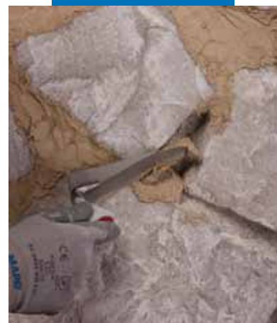
Výplň spár v kamenném zdivu
