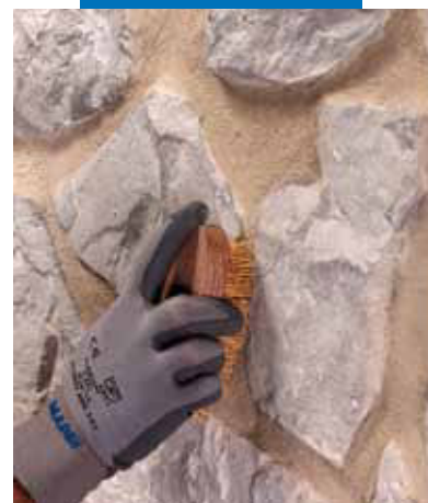
Konečná úprava povrchu kartáčem
