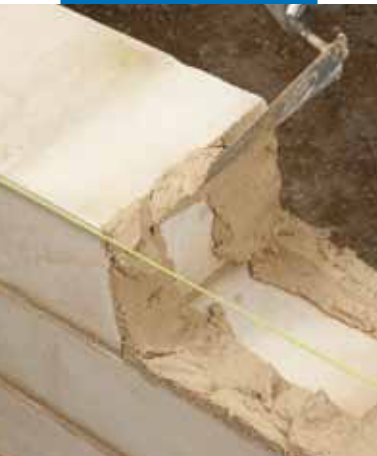
Aplikace Mape-Antique Allettamento
